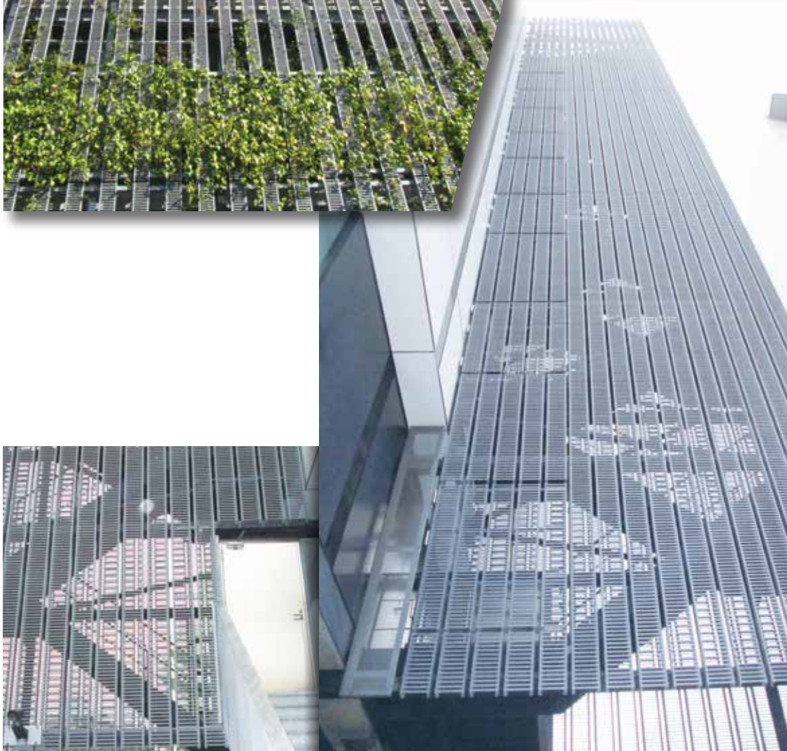
外部階段目隠し壁(MF型)
