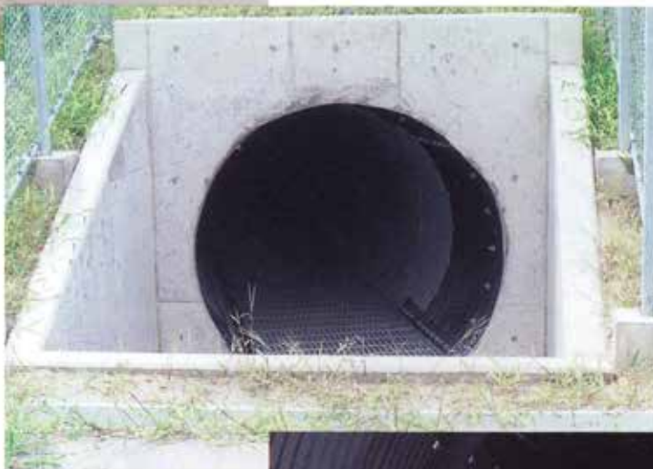
▲トンネル外観
