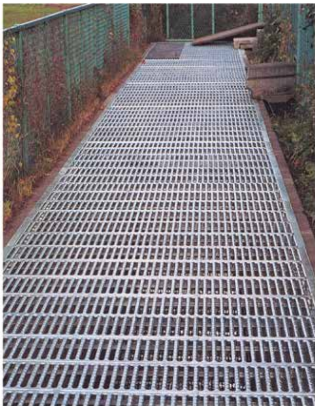
クリークウォーク施工後
