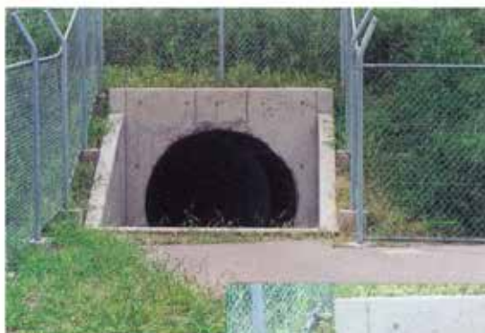
▲トンネル外観
