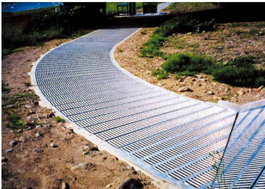
▲傾斜切断加工
