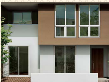
施工写真提供：住友林業株式会社
